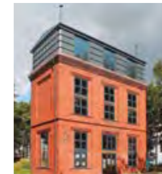
Wieża ciśnieni przebudowana na oryginalny dom jednorodzinny w Yorkshire, Wielka Brytania. AQUAREA
