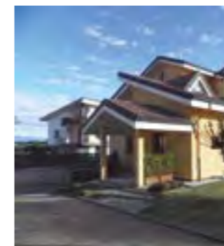
Dom dwurodzinny w Boves w gminie Cuneo, Włochy. AQUAREA
